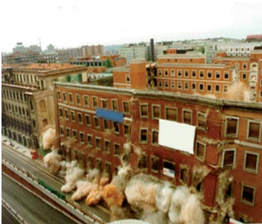
Zona de voladura protegida con láminas de PVC, para evitar proyecciones de partículas.
