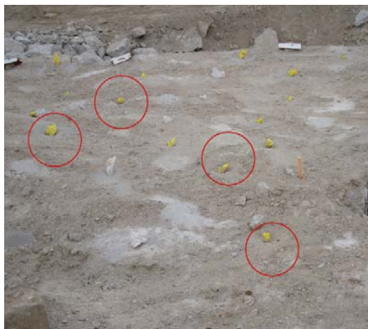
Fotografía de zona con cargas explosivas retacadas.
