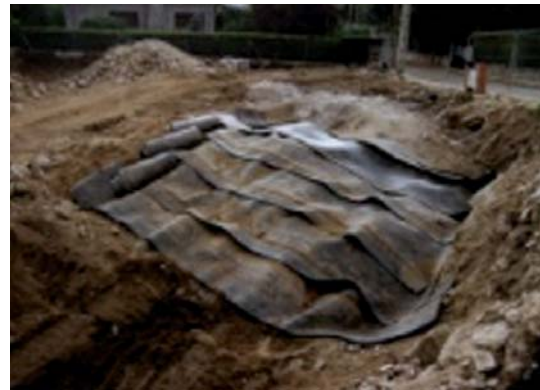
Zona de voladura protegida con láminas de PVC, para evitar proyecciones de partículas.
